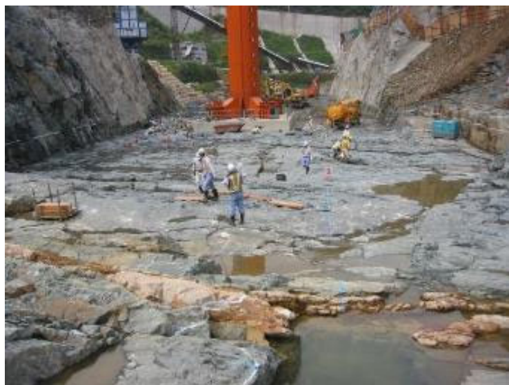
基礎掘削されたダム河床部
