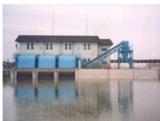
排水機場の整備
