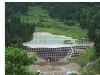
地すべり対策工事の完了
