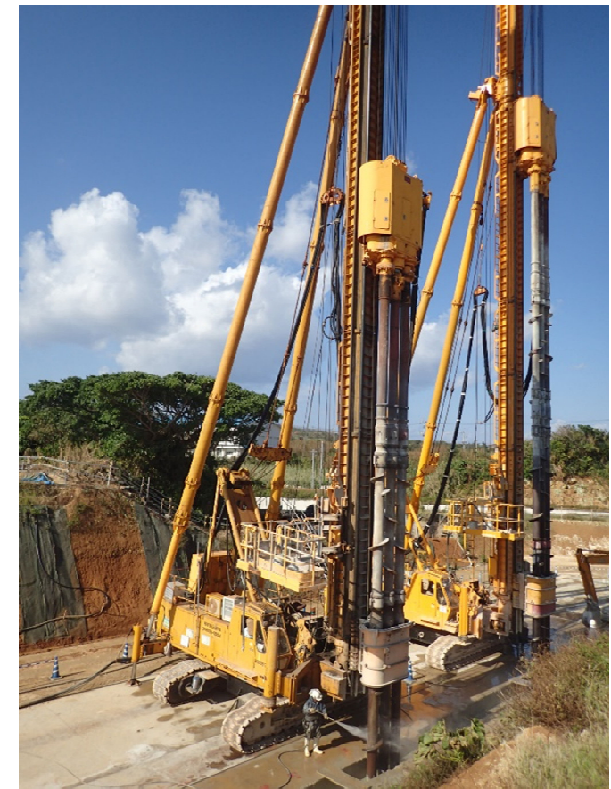
止水壁施工機械の例
