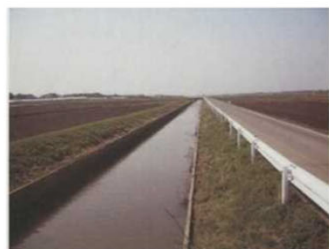
排水路の整備
